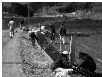
図2 防草シートの敷設
